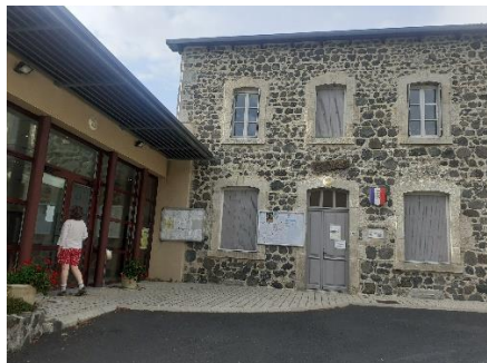
Mairie de Mézères (Haute-Loire), avec matériaux de construction locaux (FR)
